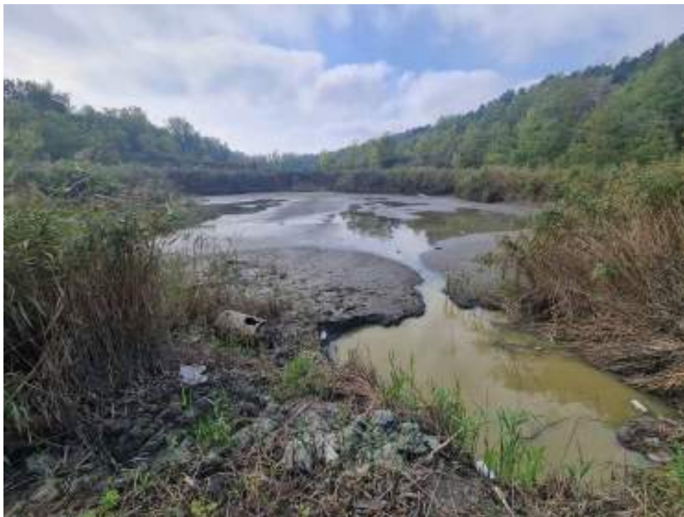
Рисунок 2.3. Загальний вид споруди після його висушування (03.10.2022 р.) вид А
