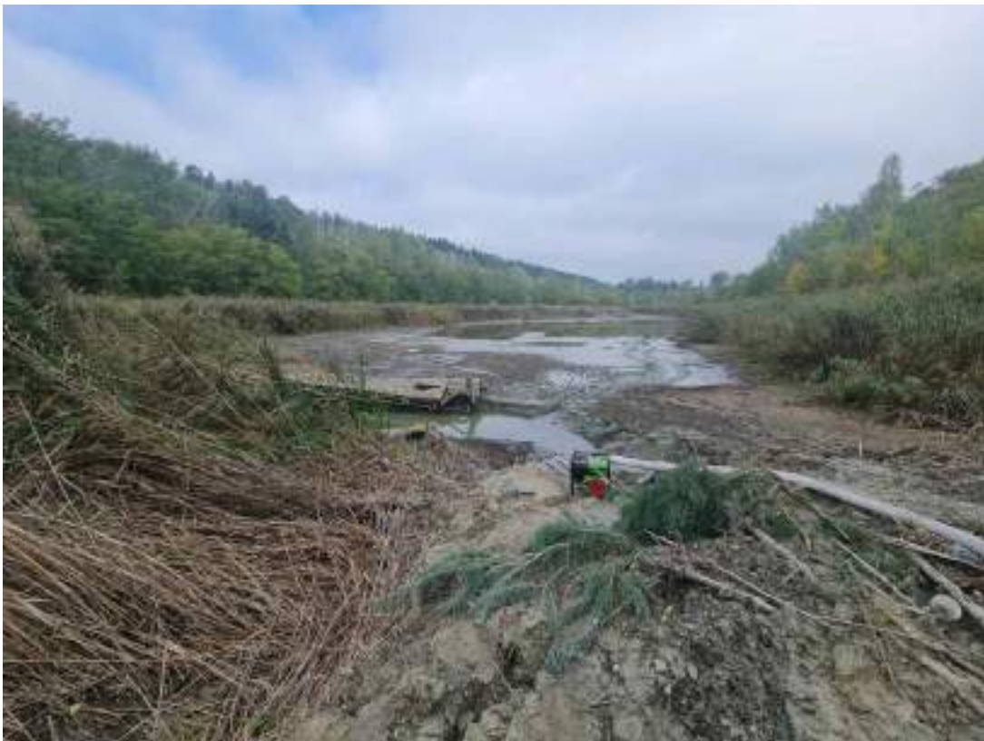
Рисунок 2.5. Загальний вид споруди після його висушування (03.10.2022 р.) вид В
