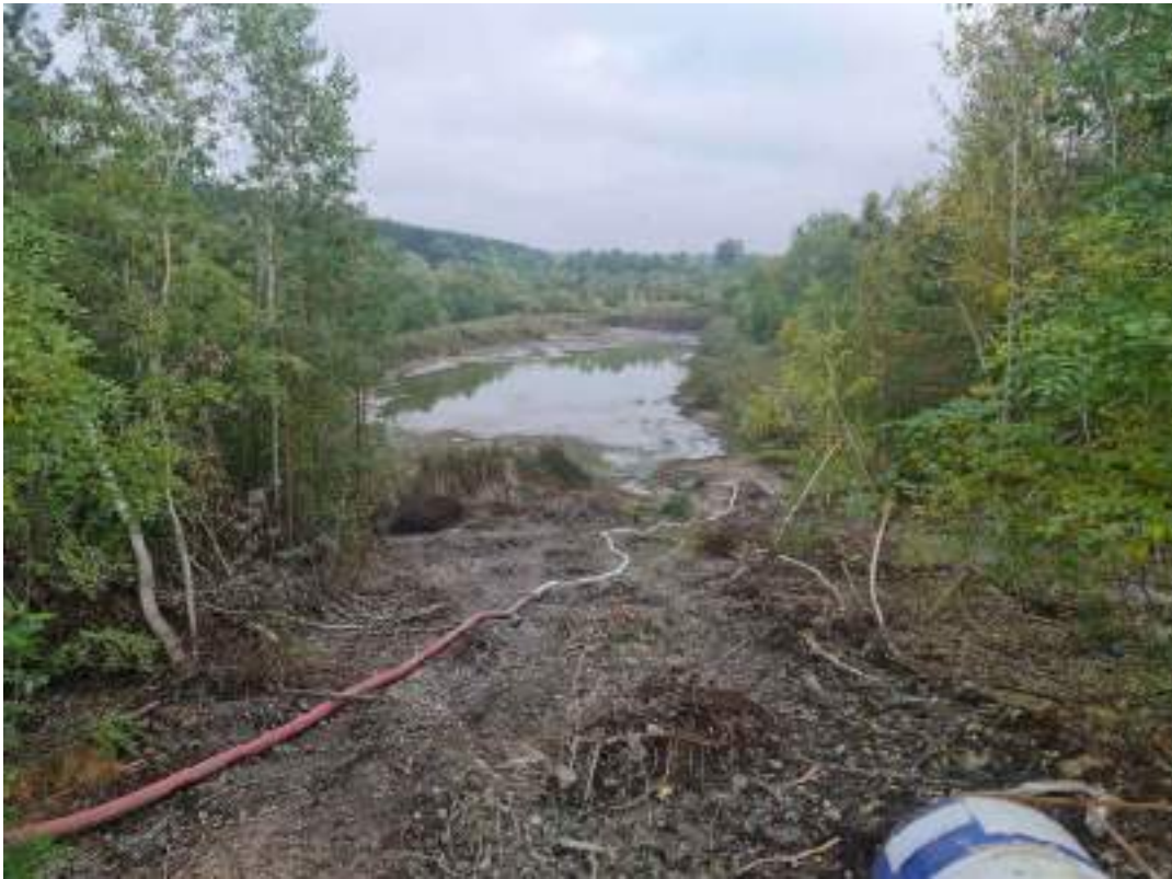
Рисунок 2.4. Загальний вид споруди після його висушування (03.10.2022 р.) вид Б
