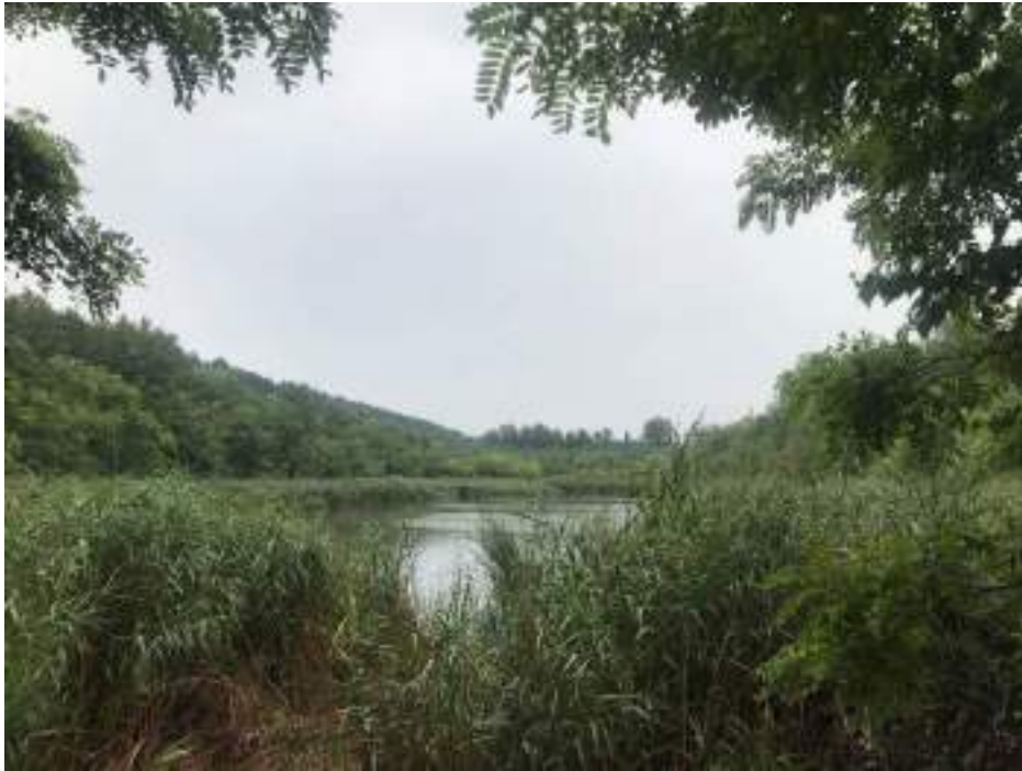
Рисунок 2.2. Загальний вид споруди до його висушування (02.08.2022 р.)
